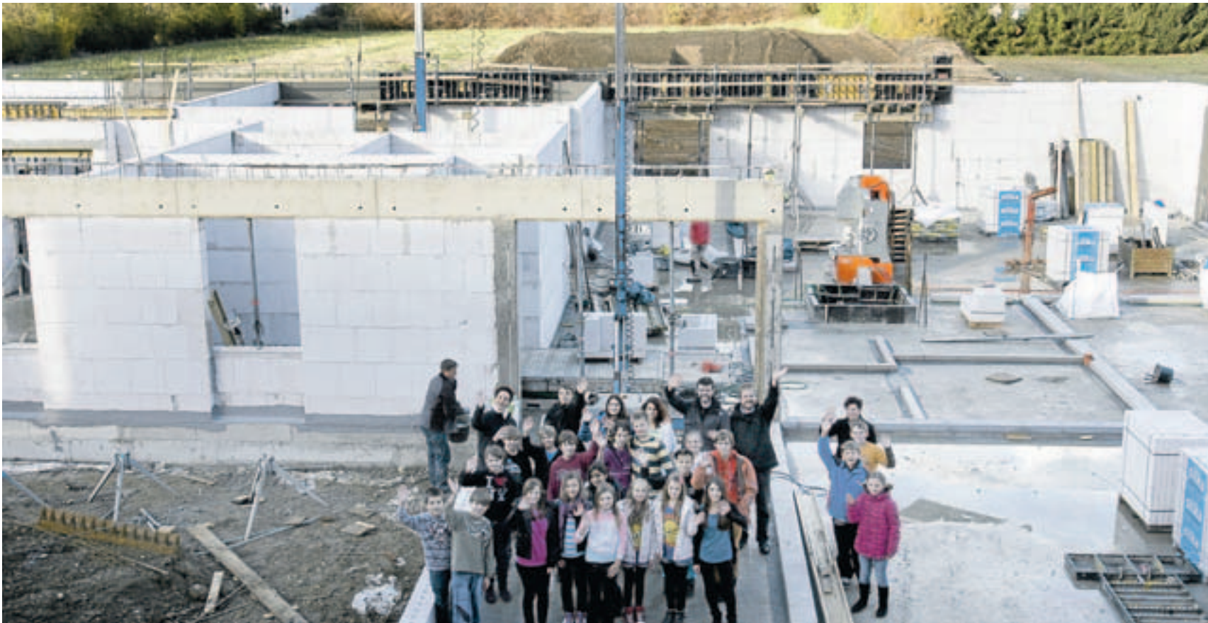
Bis zum Sommer 2013 – vor Beginn des neuen Schuljahres – soll der Anbau an der IGS Lengede fertiggestellt sein. Foto: Henrik Bode
